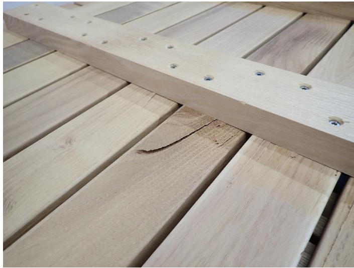
Figure 5. Vue en dessous des éprouvettes après rupture
