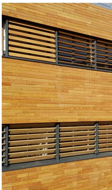
Le Robinier (faux-acacia) est la seule essence européenne réellement de classe d'emploi 4 même en contact direct avec le sol avec une durée de vie attendue supérieure à 50 ans et ce, des conditions d'humidité ambiante importante et récurrente.
