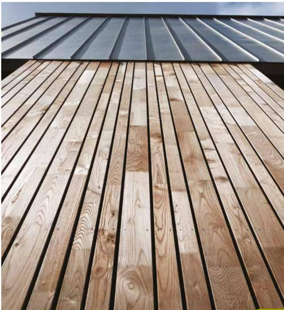
Mettre à profit les couleurs naturelles des essences, alterner les largeurs (20 x 80 mm et 20 x 125 mm) pour créer un effet de profondeur, jouer avec les matériaux bruts que sont le bois, le zinc et le béton : tel est le travail réalisé pour l'hôpital de Lannion.
