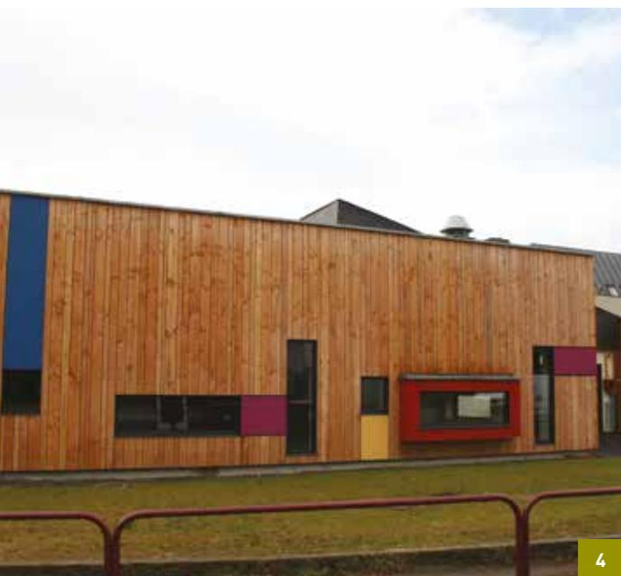
**1** Ce bardage en aspect claire-voie de sections 27 x 120 mm a été pensé pour simuler un effet « tasseaux ». Le clouage est masqué en partie haute par le recouvrement de la lame supérieure. Cette technique, conforme au DTU, permet de préserver le pare-pluie car la vêtture est ainsi protégée des agressions extérieurs (météo, vandalisme...)
